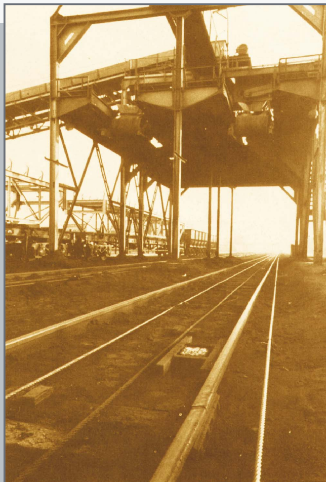
Posizionamento di cavi sotto tramoggia
